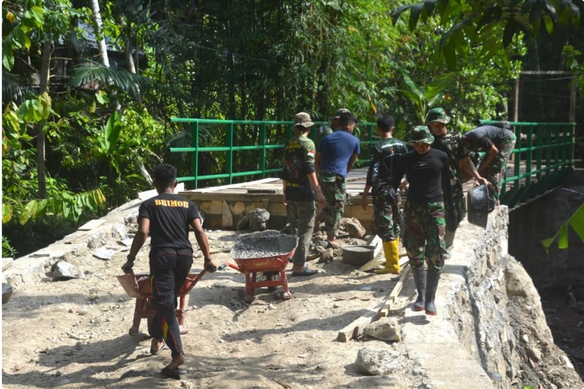
Jembatan berukuran 14 Meter x 4 Meter berbahan Besi dan Kayu Ulin, Mencapai 95 persen dibangun oleh satgas TMMMD Ke 116 Kodim 1402/Polman di Desa Ongko, Kec. Campalagian Kab. Polman Prov. Sulbar. Senin (22/05/2023)
